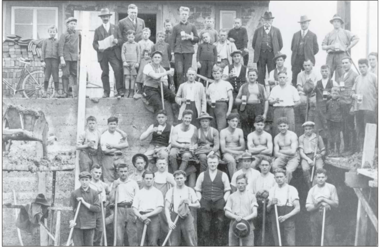
Lauter starke Kerle halfen mit beim Bau des Bädles in Weiler.
